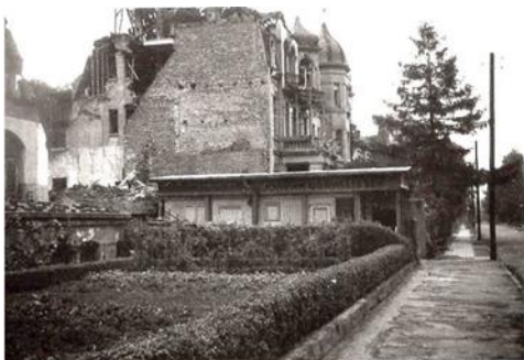
146. Dom przy Waldhausenstrasse 5 zniszczony w trakcie nalotu wojsk alianckich
